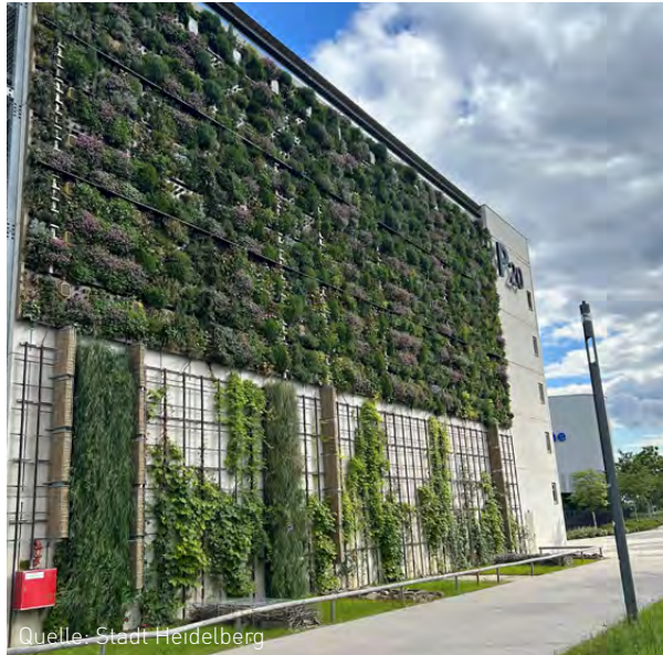
Das Parkhaus P20 in Heidelberg. Kombination aus boden- und fassadengebundener Fassadenbegrünung
