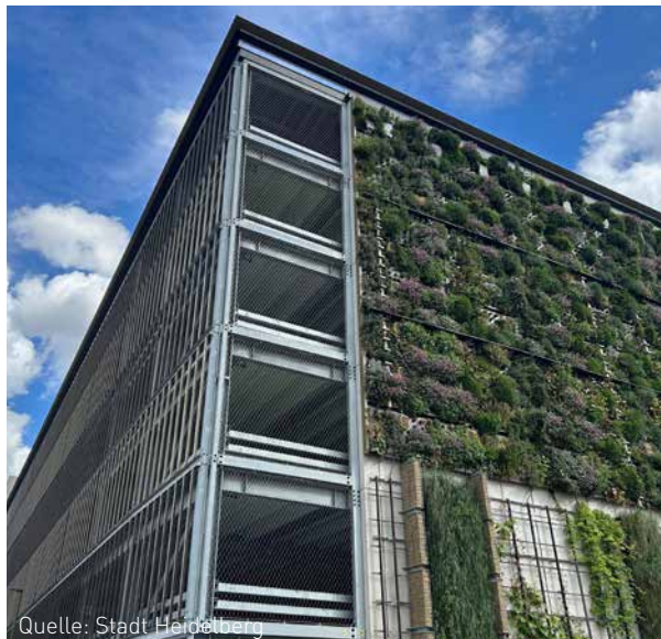
Quelle: Stadt Heidelberg Das Parkhaus P20 in Heidelberg. Üppig begrünte Rankkonstruktionen an der Fassade.
