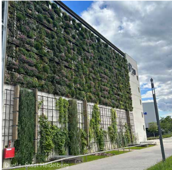
Quelle: Stadt Heidelberg Das Parkhaus P20 in Heidelberg. Kombination aus boden- und fassadengebundener Fassadenbegrünung
